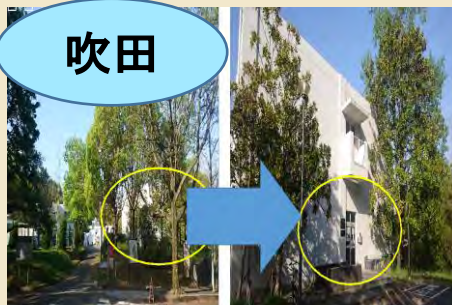
サイバーメディア教育実習棟 2階
