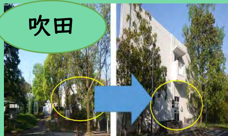
サイバーメディア教育実習棟 2階
