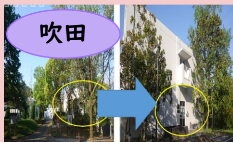
(旧サイバーメディアセンター) 吹田教育実習棟 2階
